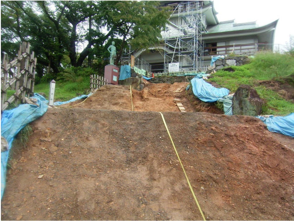
階段撤去後の歴史館南側斜面
