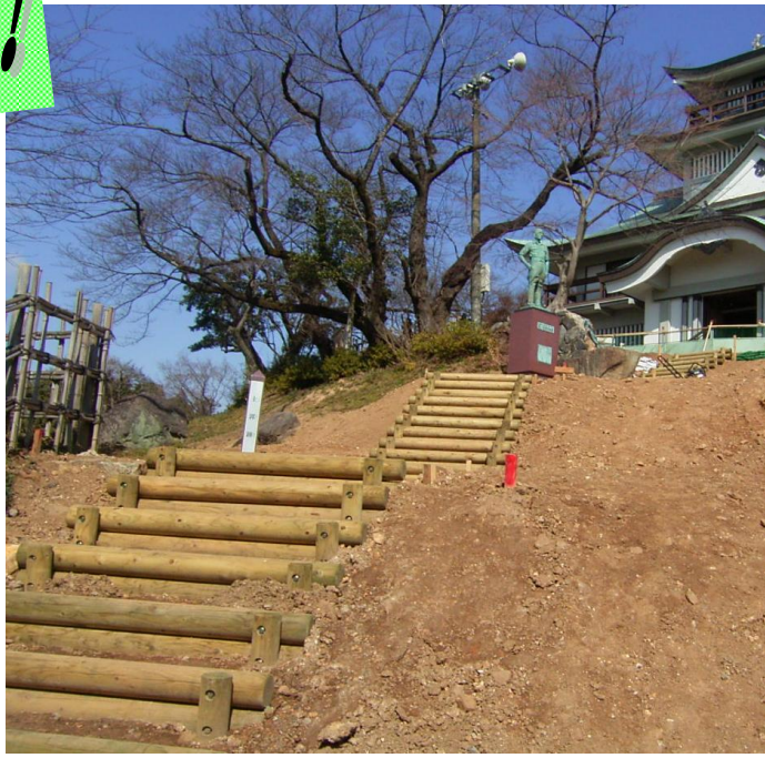
木階段で復旧中の南斜面
