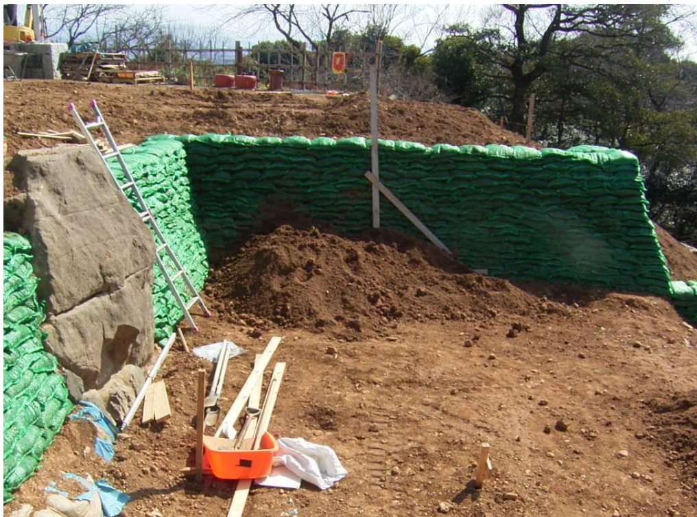
南斜面に積まれた「植生土のう」
