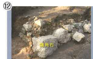
⑫ 南東斜面で隅角石を確認しました。後に一般的となる「算木積」をしていないことから、最も古い段階の石垣構築技法を知る手がかりとなりました。
