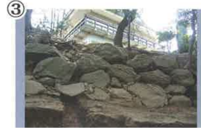
③ 石垣I。主郭北西斜面で推定される石垣Iの高度は、2.5～3.8mです。
