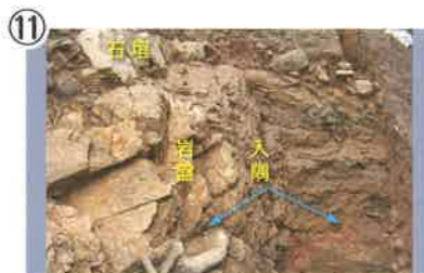
⑪ 岩盤を加工し入隅を形成し、その上に石垣を据えています。
