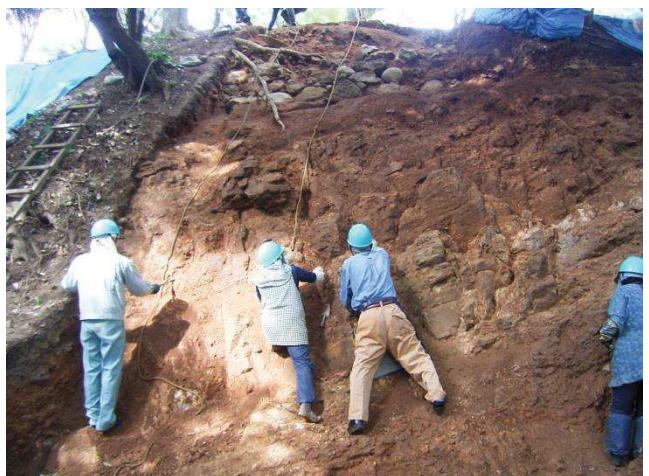
写真1 石垣と岩盤の発掘状況
