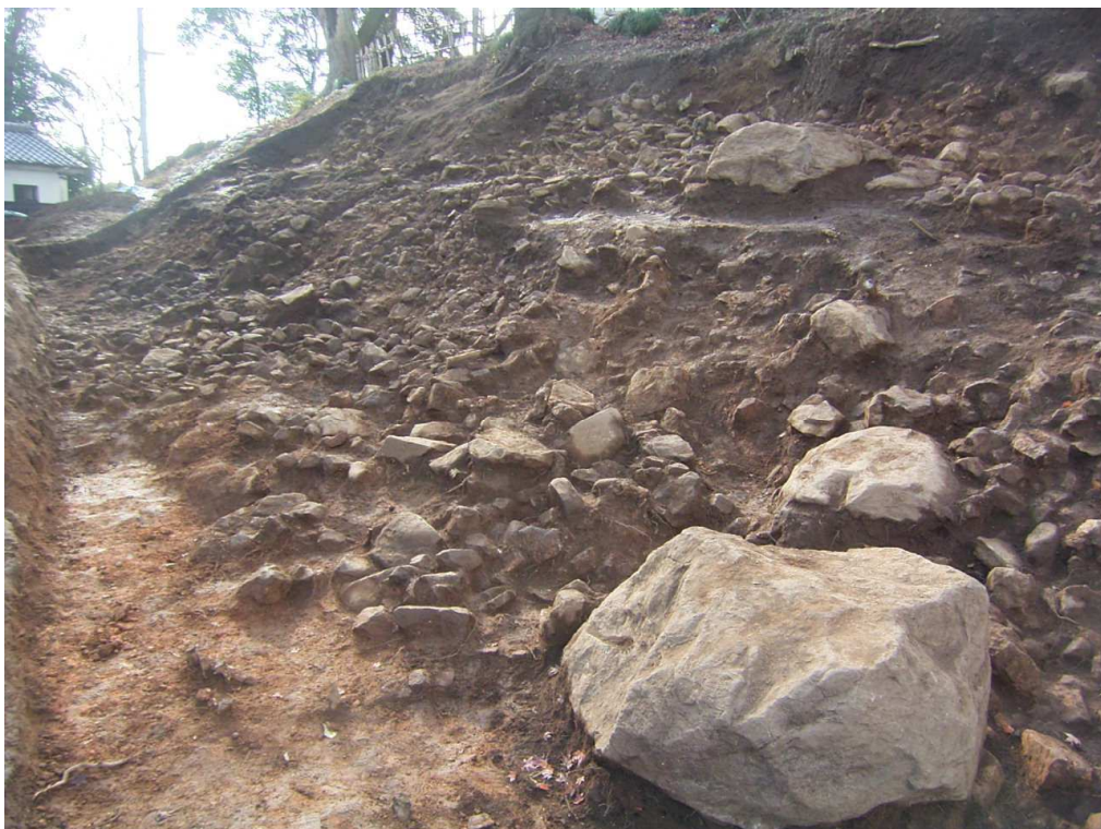
主郭北東斜面 石垣石材の転落状況
