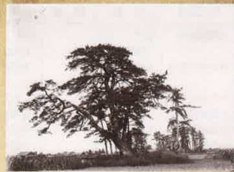
3 駒つなぎの松 —明治40年頃— 【舟橋写真機店 提供】
