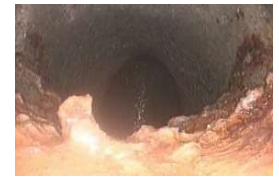
第一幼 園舎雑排水管 (C評価) 45年経過 錆瘤、堆積物
