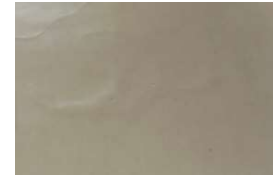
岩崎中 校舎 (B評価) 床シート浮き
