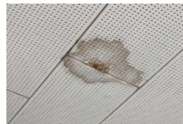
一色小 校舎 (C評価) 雨漏り跡
