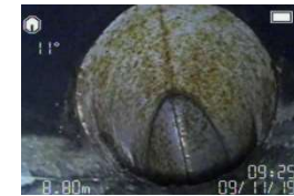
小牧中学校 雑排水管 (B評価) 22年経過 付着物
