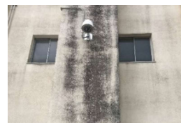
篠岡小 校舎 (C評価) 塗装劣化
