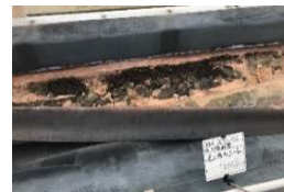
篠岡小 校舎 (D評価) 防水シート剥がれ
