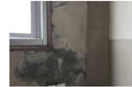
米野小 校舎 (C評価) 塗装劣化、亀裂多数
