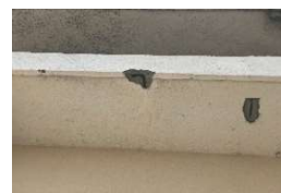
北里小 校舎 (C評価) 剥落、露筋
