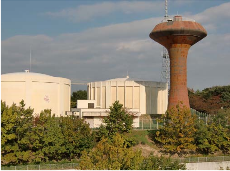
桃花台配水池 左から 桃花台1号池 管理棟 桃花台2号池 桃花台高架水槽 (平成22年11月撮影)
