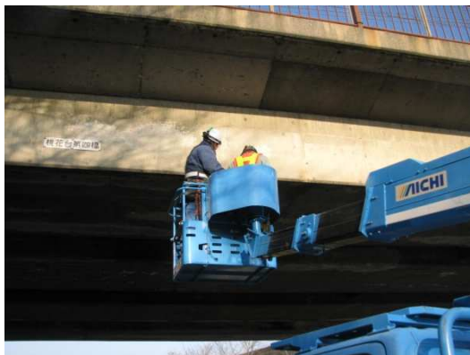
写真-3.1 専門業者による点検状況①
