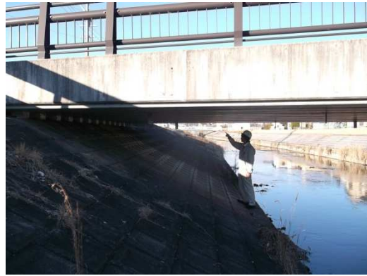
写真-3.4 職員による点検状況②
