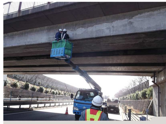
写真-3.2 専門業者による点検状況②
