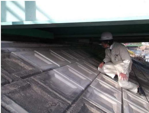
写真-3.3 職員による点検状況①
