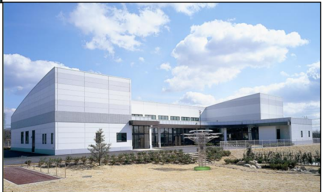
(プラザハウス)
