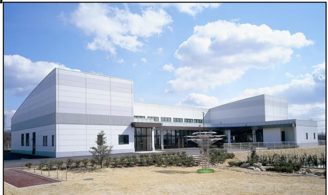
(プラザハウス)
