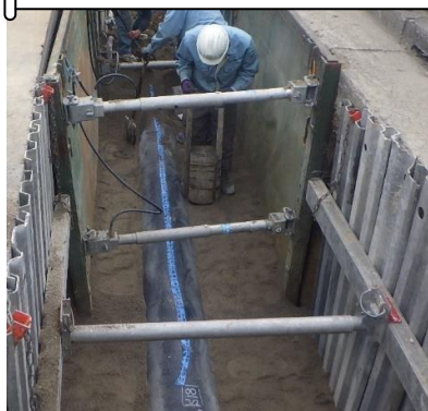
R2実施 市道犬山公園小牧線外φ400mm～φ50mm配水管布設工事
