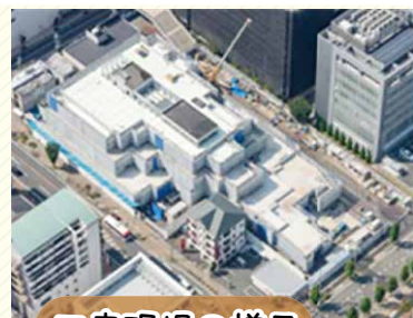
工事現場の様子
