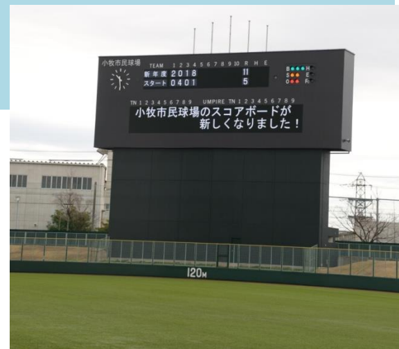
スコアボード改修
