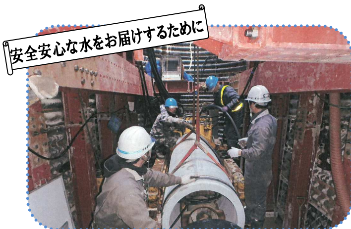
H29 実施 国道155号φ400mm配水管布設替工事
