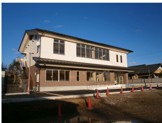
小牧原街道会館 (平成25年度施工)
