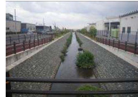
整備完了箇所
