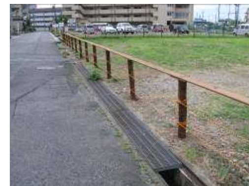
土地管理事業による 用地管理柵の修繕後
