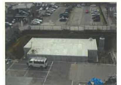
雨水対策事業 (市役所 平成23,24年度施工)
