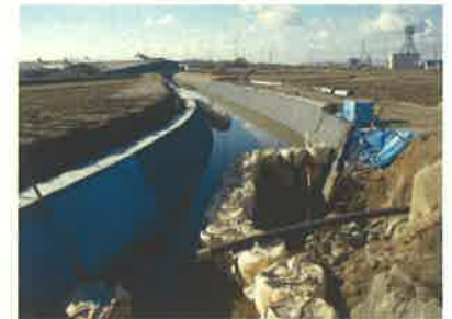
道木川整備事業 (平成24年度施工)
