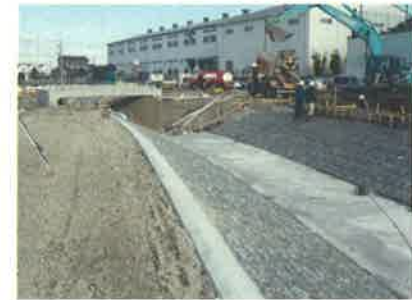
小針川整備事業 (平成24年度施工)
