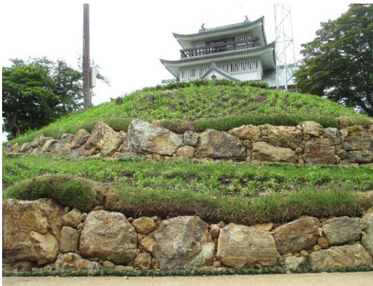
令和3年度に実施した整備で復元した石垣(歴史館北側)
