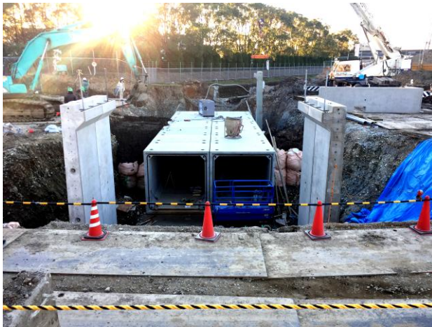
河川水路整備事業 (新濃尾土地改良関連整備事業)
