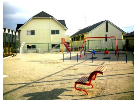
本庄台第2児童遊園 (平成28年度施工)
