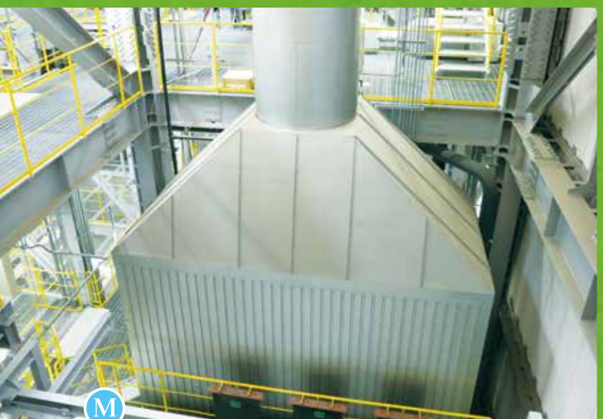
K ろ過式集じん器 排ガスに含まれるばいじん、重金属類をろ布(フィルター)で捕集します。
