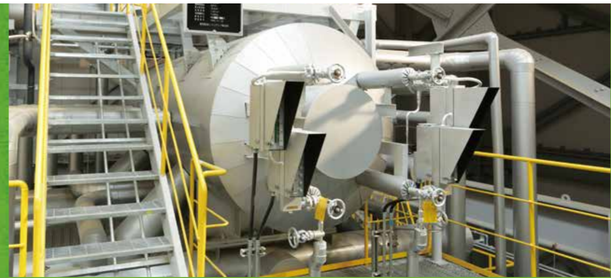
O ボイラ 燃焼室より送られた高温ガスとの熱交換により蒸気を作ります。蒸気は蒸気タービンに送られます。
